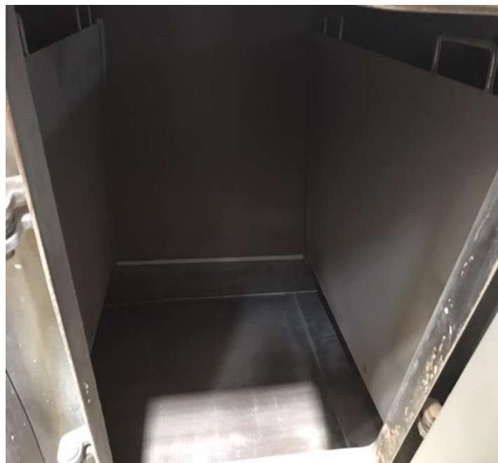
Figura 4.20 - Visão interna da Câmara demonstrando leito e passagem entre as placas e aberturas abaixo das divisórias. (Autor, 2020).
