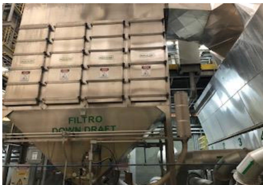
Figura 4.15 – Filtro coletor de particulados. (Autor, 2020).
