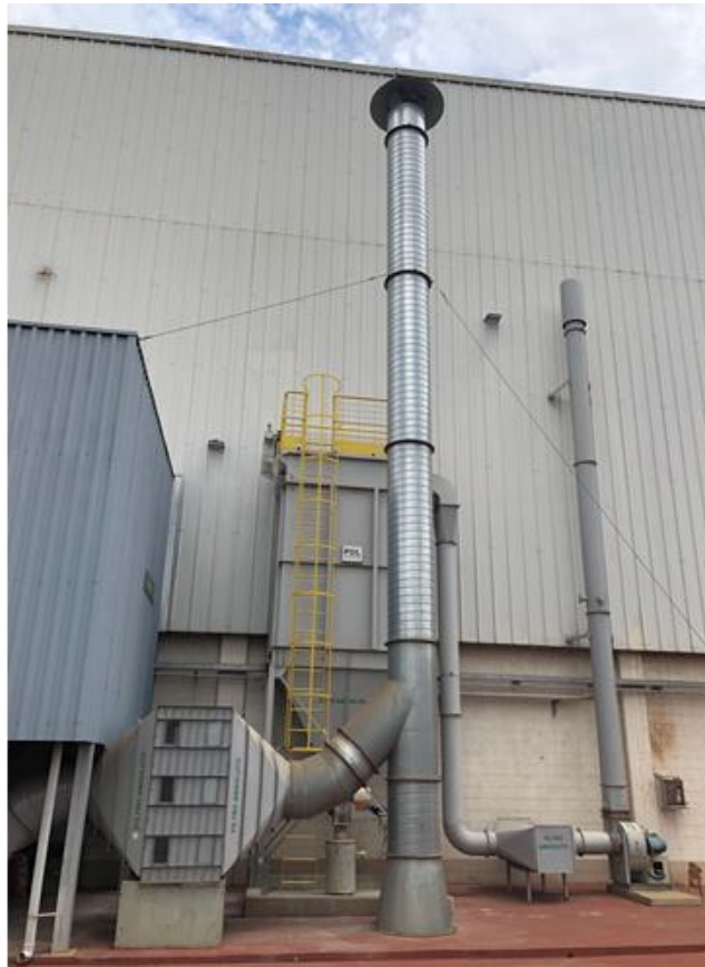
Figura 4.21 - Sistema de coleta e saída do ar atmosférico. (Autor, 2020).
