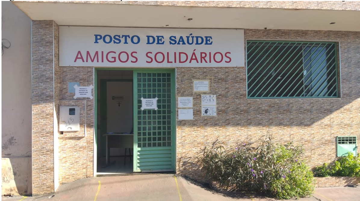
Figura 2 – Portaria e sala de espera da ESF/PSF Planalto
