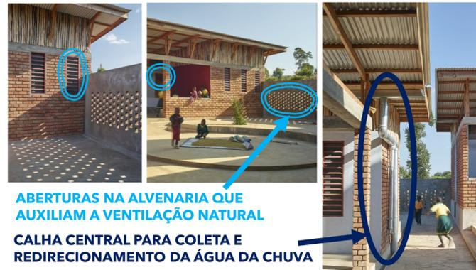
**ABERTURAS NA ALVENARIA QUE AUXILIAM A VENTILAÇÃO NATURAL**
