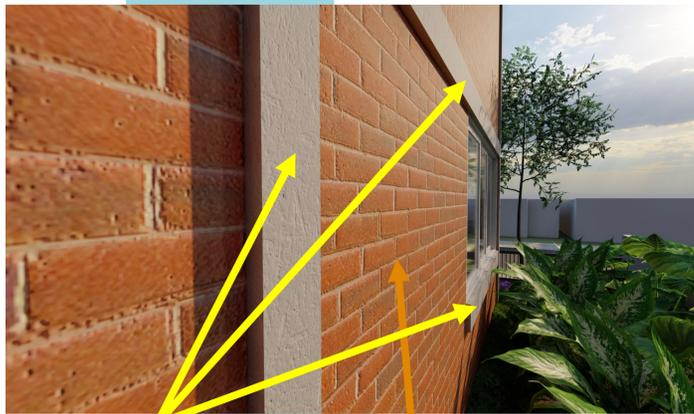
**ESTRUTURA DE CONCRETO APARENTE**      **TIJOLINHO APARENTE**
