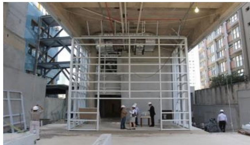
Imagem 14 : Início das obras da nova unidade do hospital GRAACC.
