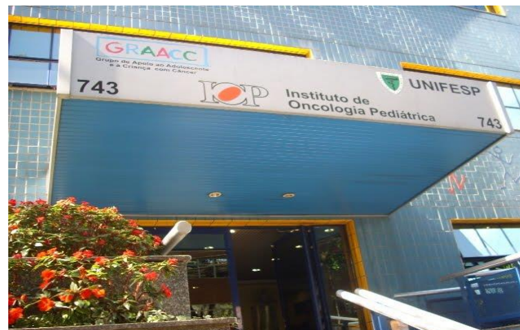
Imagem 11: Acesso principal do GRAACC antes da reforma. Fonte: www.feapaesp.org.br
