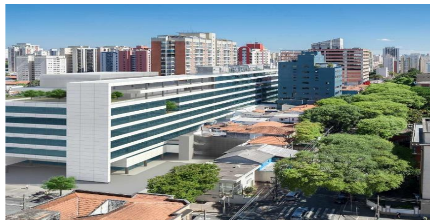
Imagem 15: Anexo e a integração do ambiente com o já construído.
