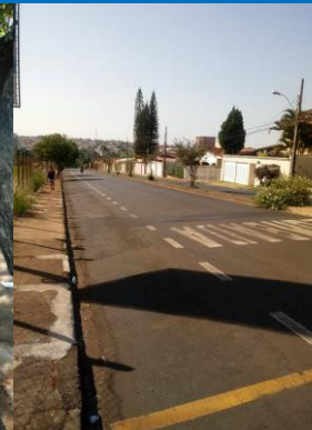
Figura 47. Vista da avenida General Osório. Foto: Do autor, 2019.
