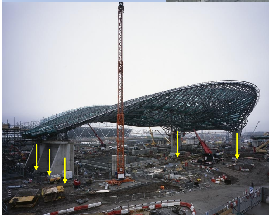
Figura 23. Construção da cobertura do Centro Aquático de Londres Fonte: www.archidaily.com . Acesso em Abril de 2019.
