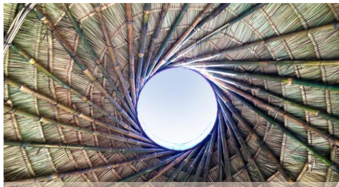
Figura 19 – Cobertura dos sanitários, executada em bambu. Fonte: ArchDaily.
