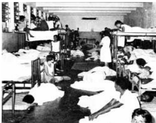
Figura 6 - Quarto coletivo do SAM - Serviço de Assistência a Menores
