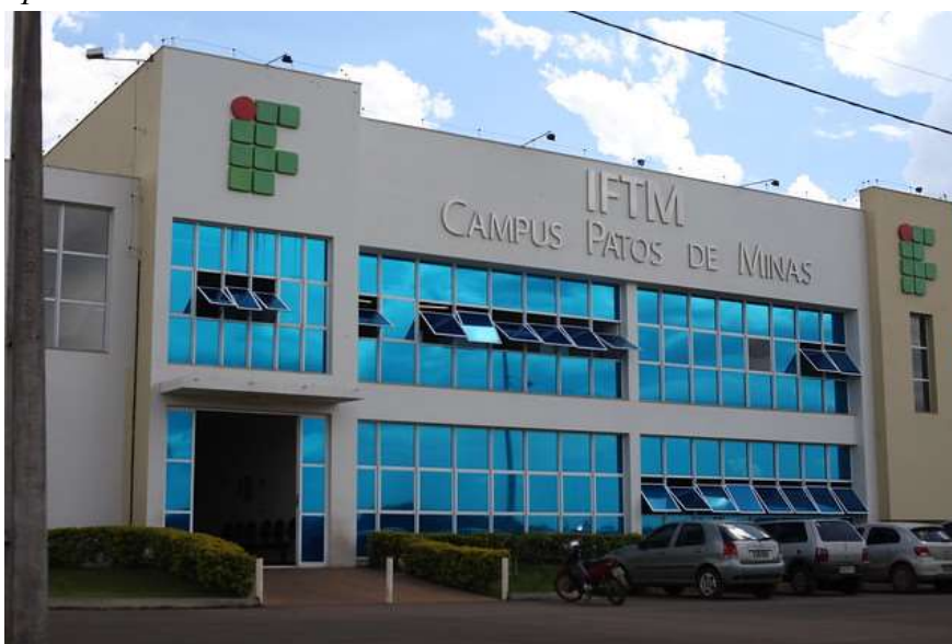
Figura 5: Campus Patos de Minas
