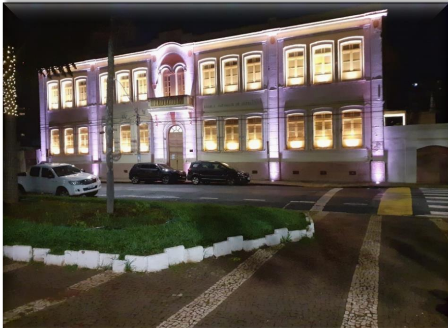
Figura 6: Vista frontal, atual da Escola Estadual de Uberlândia (Museu), Uberlândia - MG
