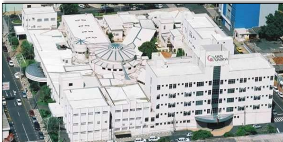
Hospital Santa Genoveva (2024)
