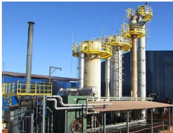
Figura 3- 3 – Sistema de filtragem úmida do tipo Filtro Depurador.
