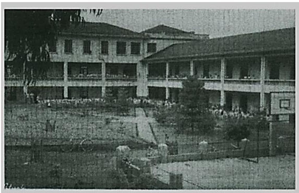
Figura 83 – Espaço do pátio central com parte da quadra de esportes
