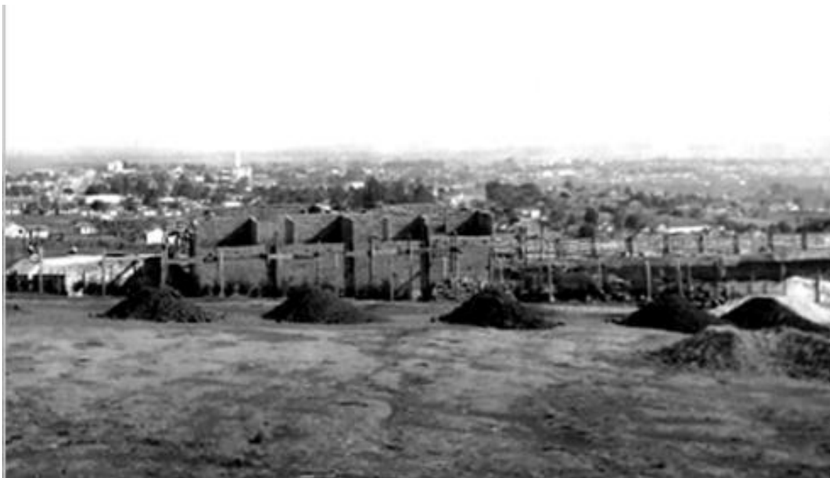
Figura 68 – Terraplanagem e avanço das obras (paredes de alvenaria sendo erguidas)
