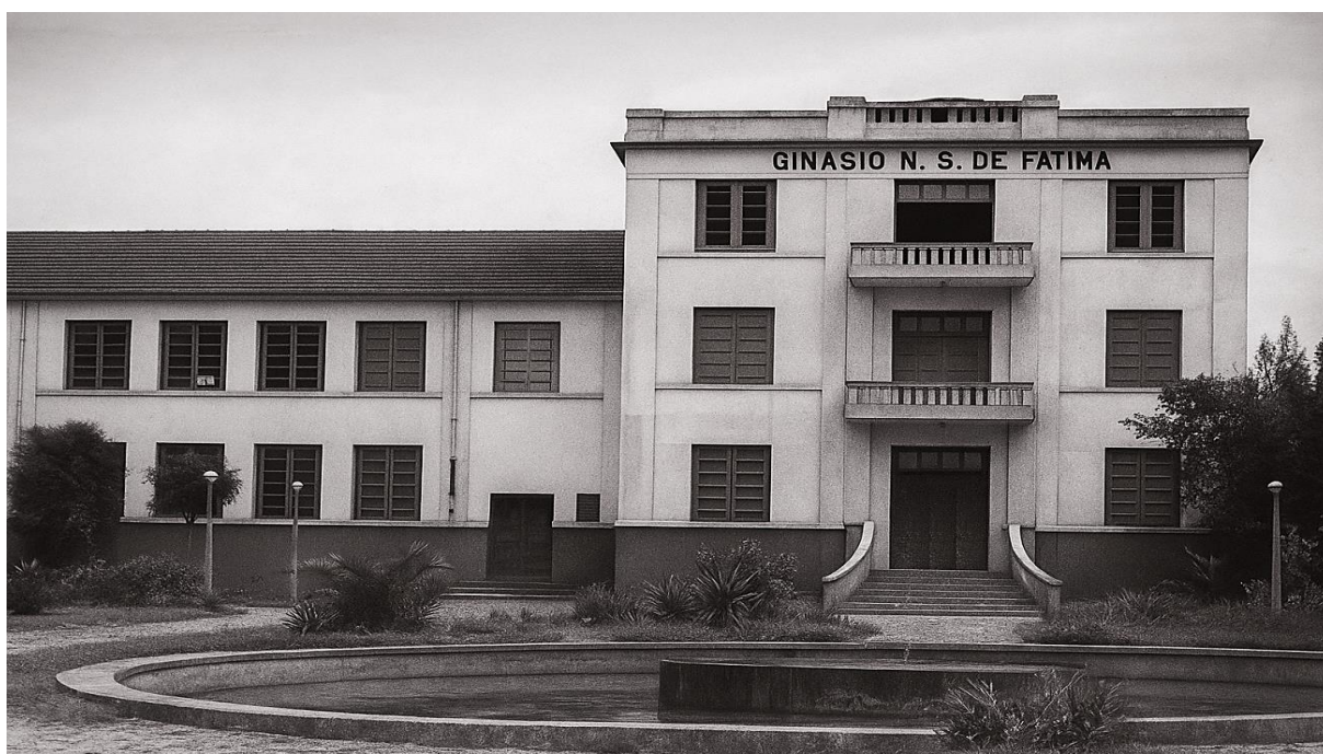
Figura 75 – Fachada, fonte luminosa e jardins (1959)
