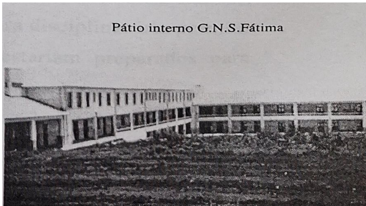
Figura 72 - Pátio Interno em terra solta (1959)
