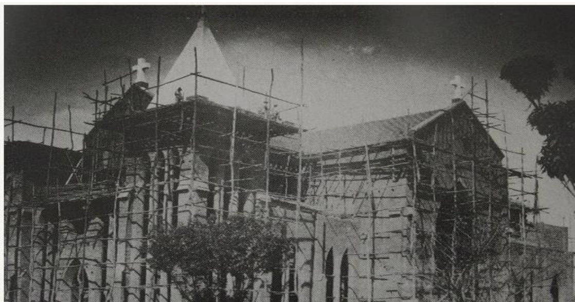
Figura 36 – Nova Matriz de Santo Antônio em construção; década de 1940
