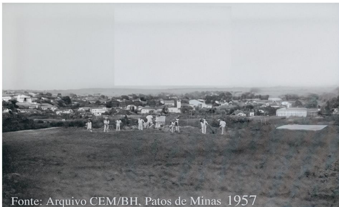
Figura 67 – Primeiros operários na construção do colégio (CEM/BH, 1957)
