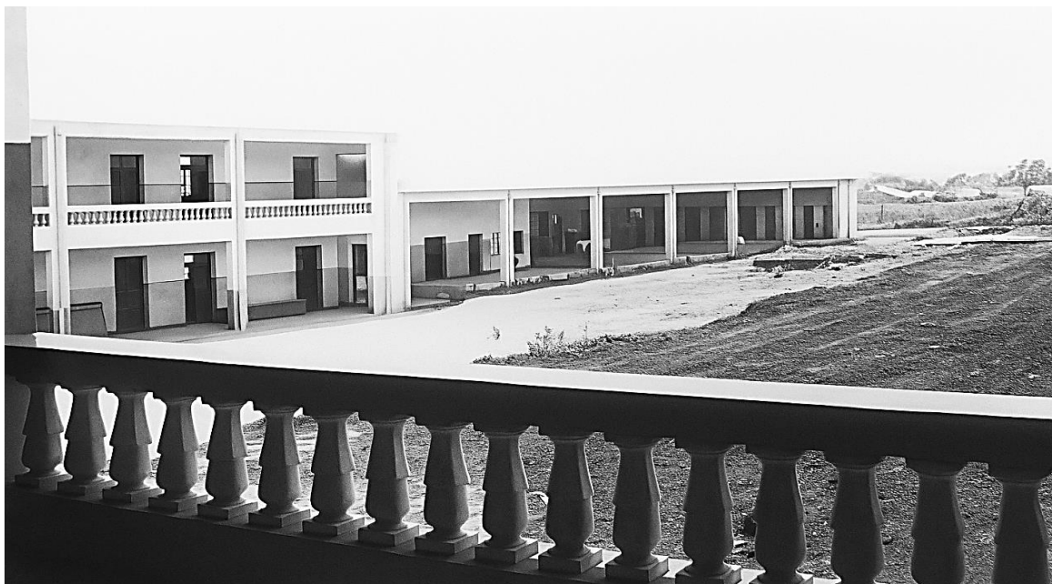
Figura 73 – Nivelamento dos pátios do colégio (1959)
