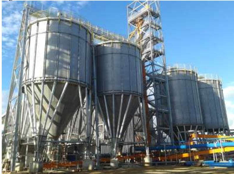
Figura 4 - Silos de armazenamento e malte
