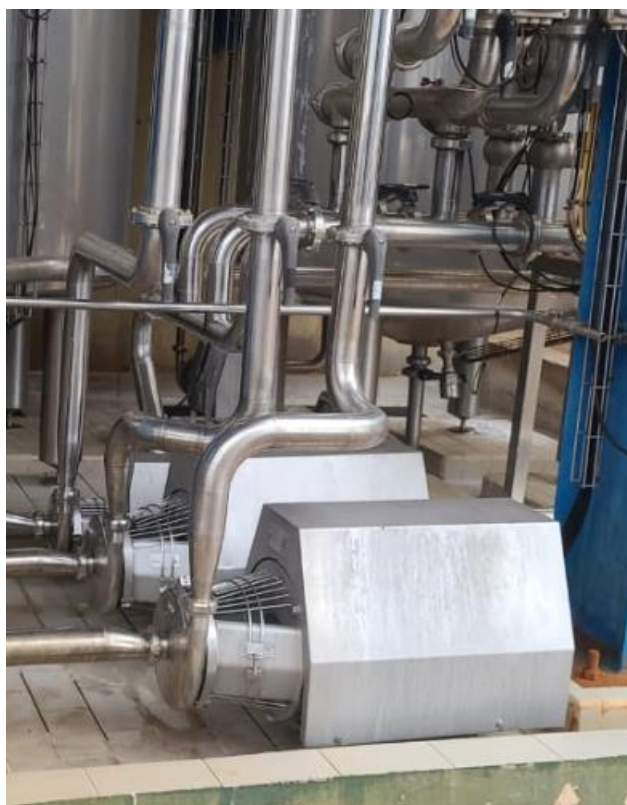
Figura 34: Três bombas de recalque de solução da Central CIP que distribuem para três plantas (Manteiga, Cream Cheese , Sem uso). Fonte: Do autor (2024).
