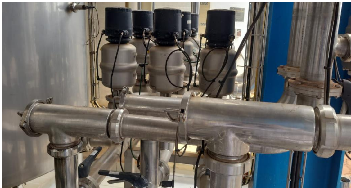
Figura 35: Sistema de filtros antes do retorno de solução para os tanques. Fonte: Do autor (2024).
