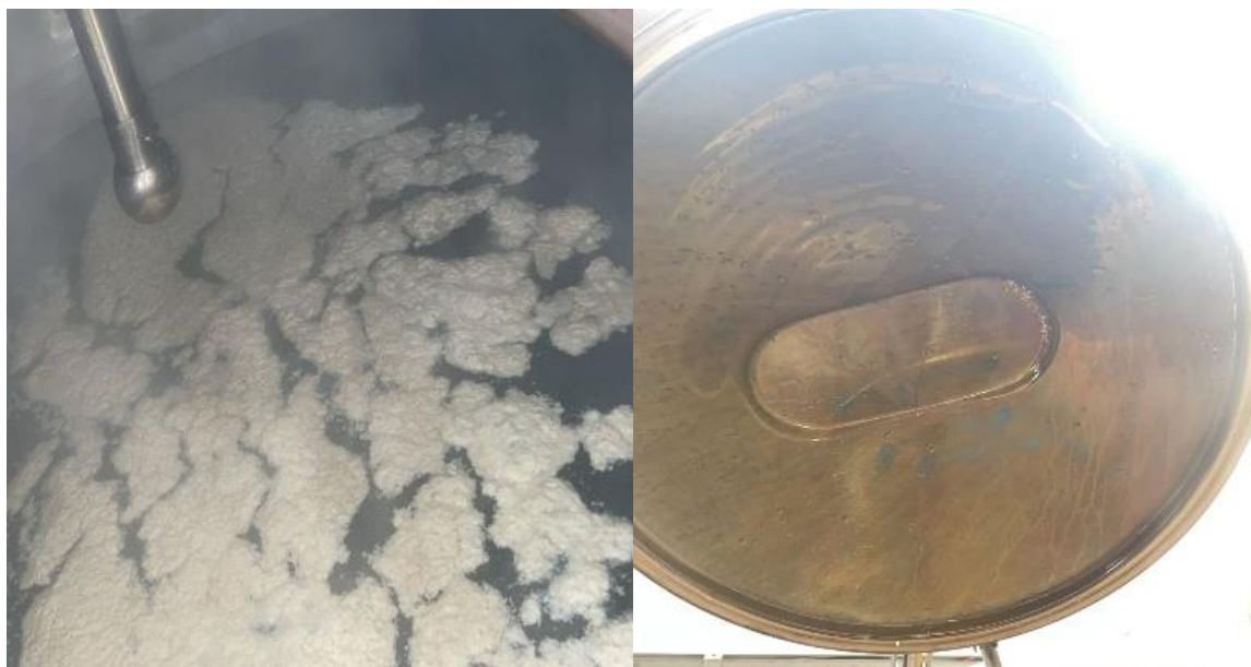
Figura 46: Residual orgânico no tanque de água recuperada da Central CIP. Fonte: Do Autor (2024).
