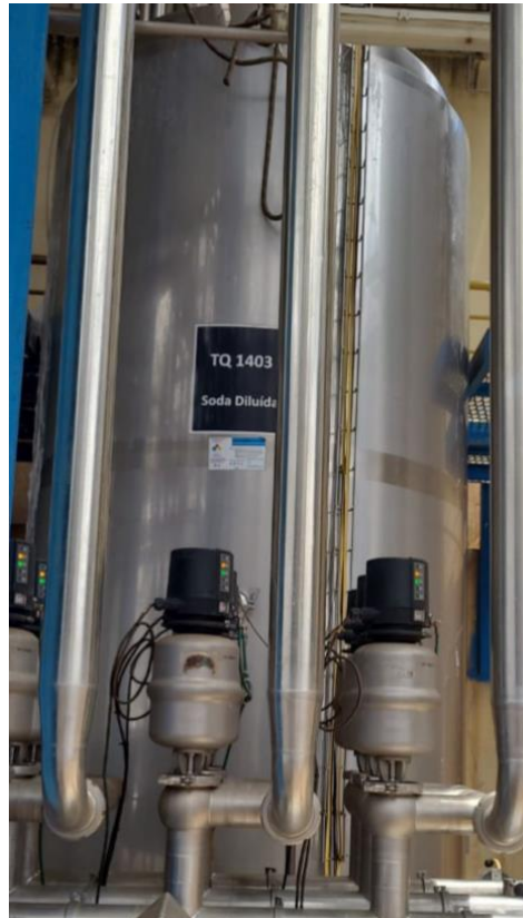
Figura 32: Tanque de solução alcalina diluída da Central CIP. Fonte: Do autor (2024).
