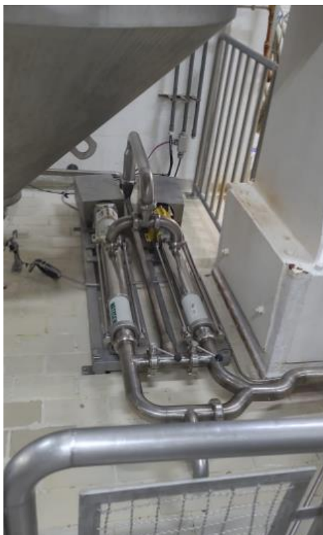
Figura 23: Bomba de envio da bateadeira para funis de envase. Fonte: Do autor (2024).
