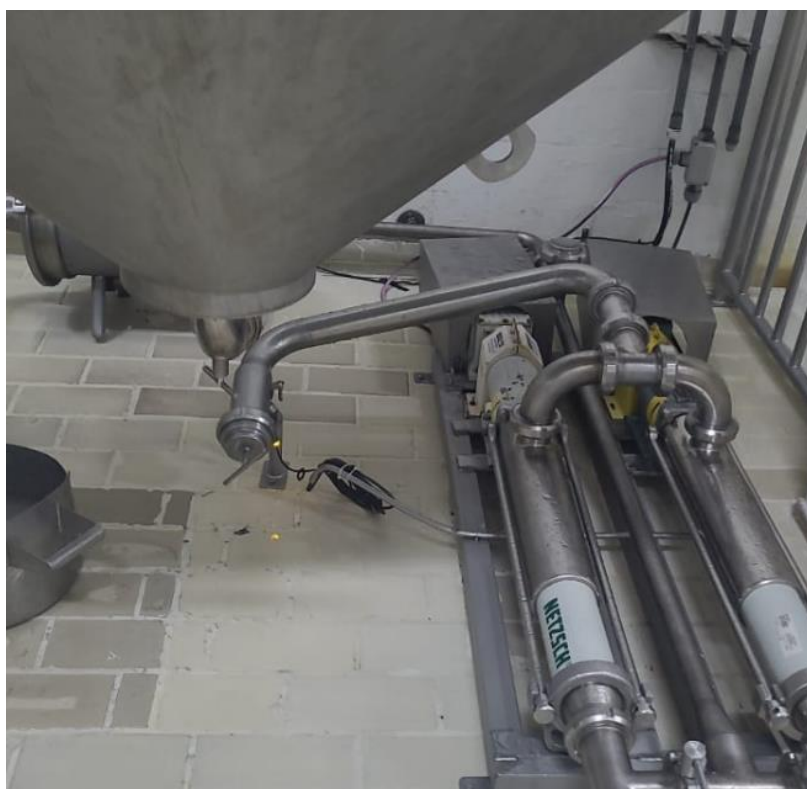
Figura 50: Tubulação vedada e limpa entre remessas.
