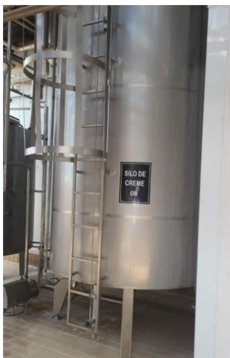
Figura 52: “Silo 8”, utilizado para armazenar água para lavar a manteiga.
